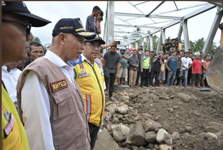
Pemantauan jembatan terban menuju BIM, Padang Pariaman
