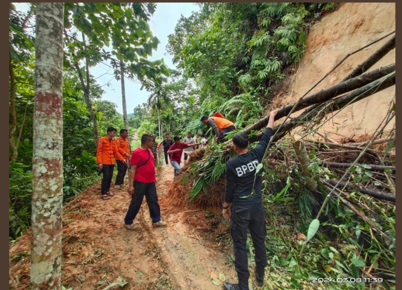
Longsor Nag. Indudur Kec. IX Koto Sungai Lasi
